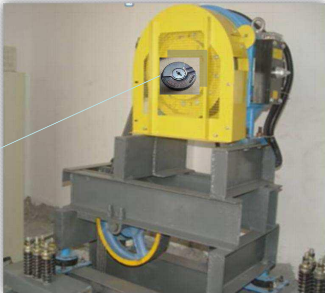
MOTOR NÃO ENGRENADO (GEARLESS) SÍNCRONO COM ENCODER
