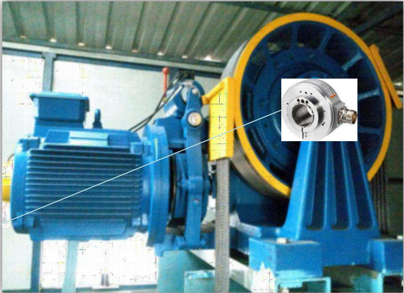
MOTOR ENGRENADO(GEARED)/ ASSÍNCRONAO COM ENCODER
