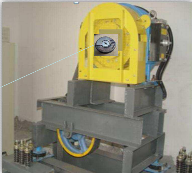
MOTOR NÃO ENGRENADO (GEARLESS) SÍNCRONO COM ENCODER
