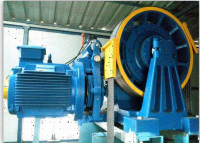
MOTORENGRENADO / ASSÍNCRONO
