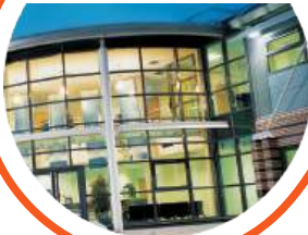
DISTRIBUIÇÃO DE ENERGIA ELÉTRICA
